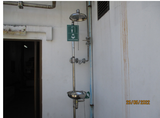
รูปที่ 36 อ่างล้างตาฉุกเฉิน
