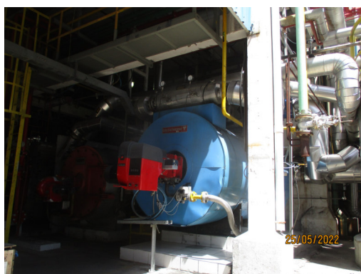
รูปที่ 2 หน่วยผลิตน้ำมันร้อน (HM Heater)
