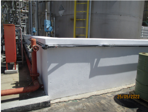
รูปที่ 34 Dike Wall/Dyke Wall
