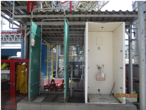
รูปที่ 36 อ่างล้างตาฉุกเฉิน
